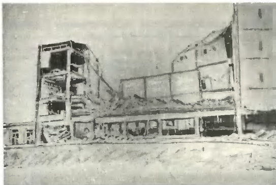
Север Ленинакана. Относительно гибкое каркасное здание.
