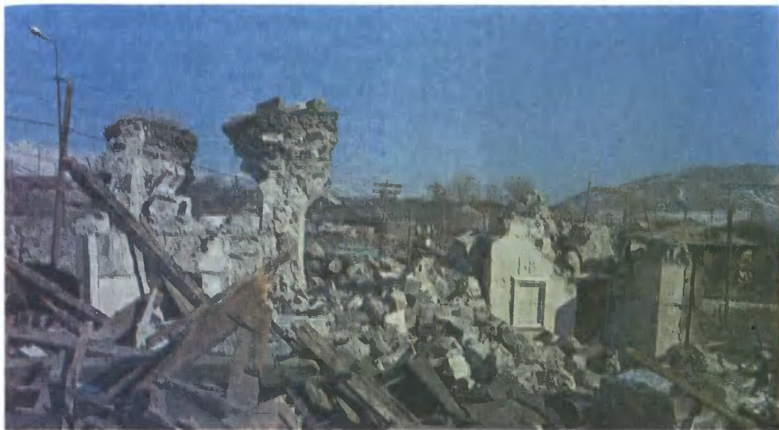
Остатки Анийского собора в Ани. Построен в 980—1101 гг. Купол рухнул при землетрясении 1319 г.
