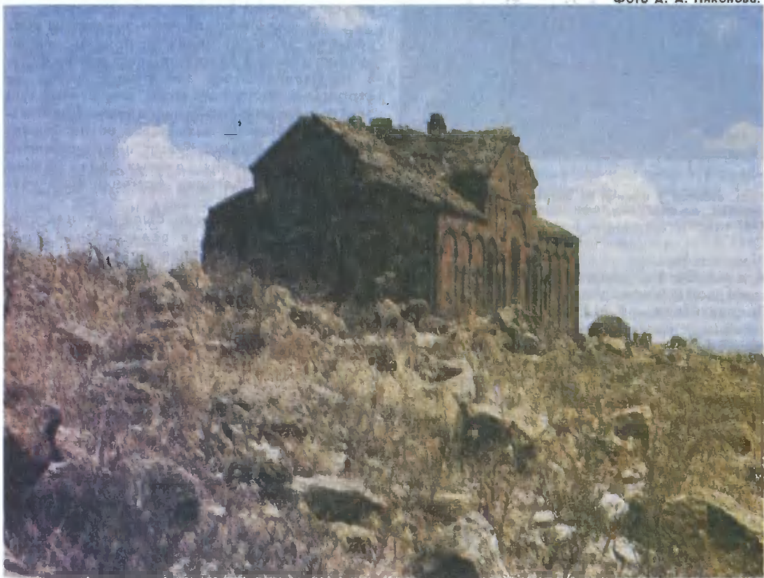
Построенная в XIX в. без антисейсмических приемов церковь в пос. Ширакмут (10-балльная зона) разрушилась при Спитякском землетрясении.
