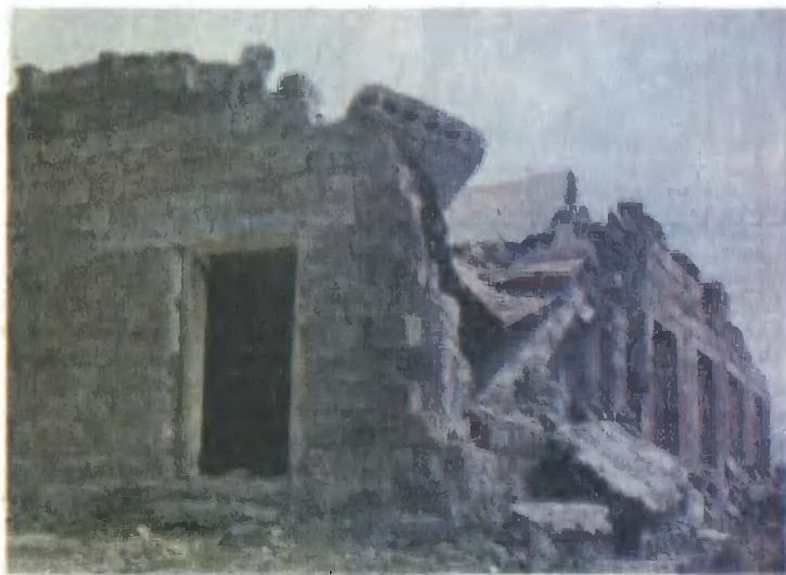
Разрушенная церковь в селении Ши́ракамут.
